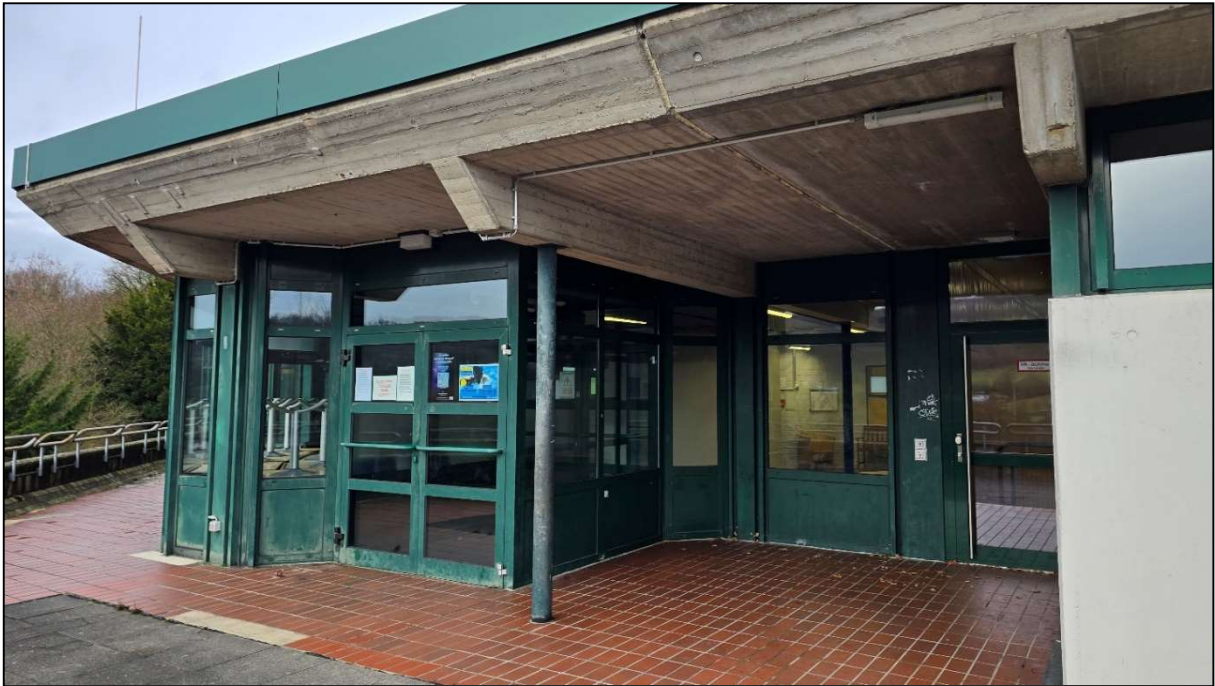
Foto 2: Ansicht Haupteingang (Südansicht)
