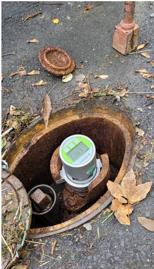
Anhand eines zuvor erarbeiteten Messstellenplans richtete man zuerst die temporären Druckmessstellen (mit Datenloggern) an den entsprechenden Stellen (Hydranten, Schächte) im Rohrleitungsnetz ein, die dann sofort mit der Aufnahme von Messdaten begannen (s. Abb.).
