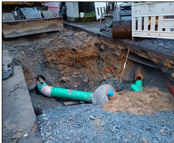
Kanalansierung „Hammerstraße“ Auftragssumme: 1.673.086,87 €
