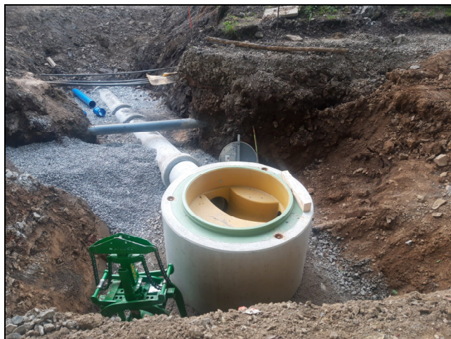
Kanalneubau „Halstenbachstraße“ Auftragssumme: 365.891,62 €
