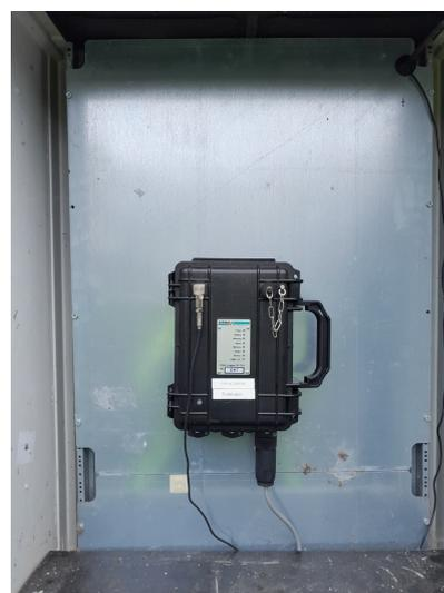
Die 25 ausgelieferten Datenlogger aus 2023 zur Überwachung der Wasserverluste wurden eingebaut und erfolgreich in Betrieb genommen. Weitere 18 Datenlogger wurden Ende 2023 bestellt, die dann fortlaufend in 2024 in Betrieb genommen werden. Es ist geplant bis Mitte 2024, 58 Datenlogger zur Überwachung des Trinkwassernetzes verbaut zu haben.
