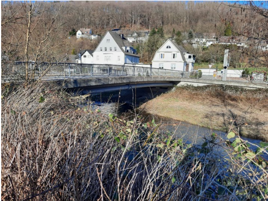
Blick auf die Aggerbrücke (Blick Richtung Norden / in Fließrichtung)
