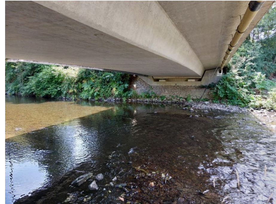
Flussbett unter der Aggerbrücke (Blick Richtung Westen)
