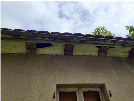
Abb. 10 Öffnung zum Dachstuhl.
