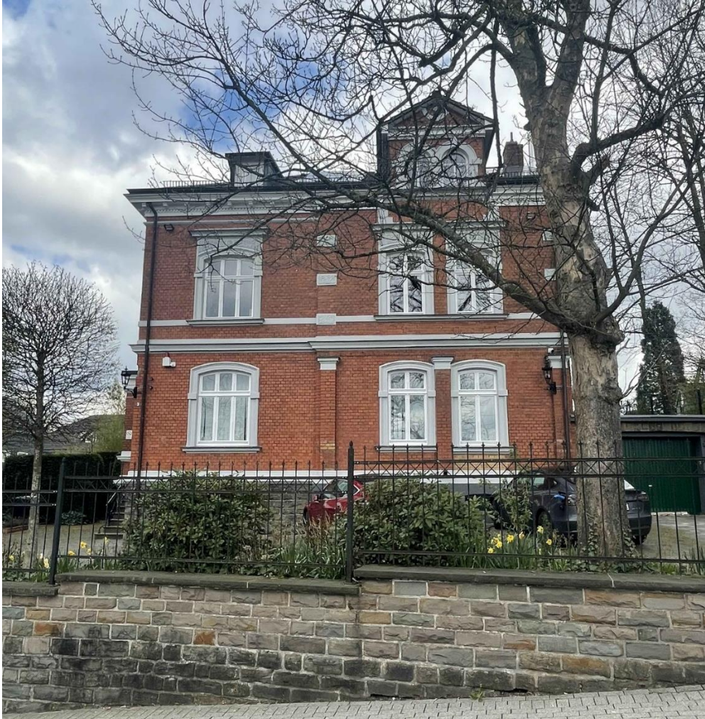
Gummersbach, Kleine Bergstraße 3, Straßenseite mit Einfriedung, Foto: Nadja Fröhlich (NF), LVR-ADR 2023.
