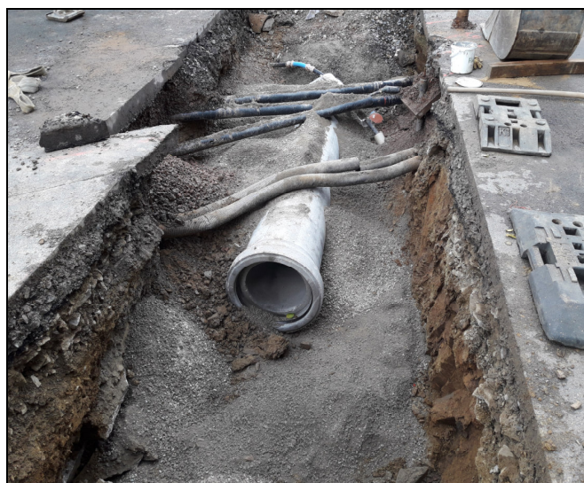
Kanalsanierung „Berghausener Straße“ Auftragssumme: 567.862,69 €
