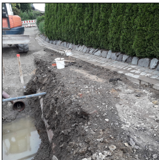
Kanalsanierung „Am Steinbergshof“ Auftragssumme: 367.000.- €
