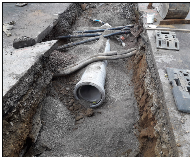
Kanalsanierung „Berghausener Straße“ Auftragssumme: 567.862,69 €
