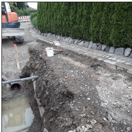
Kanalsanierung „Am Steinbergshof“ Auftragssumme: 367.000.- €
