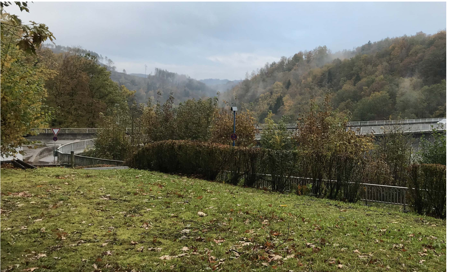
Abb. 25: Staumauer - Wenig Aufenthaltsqualität
