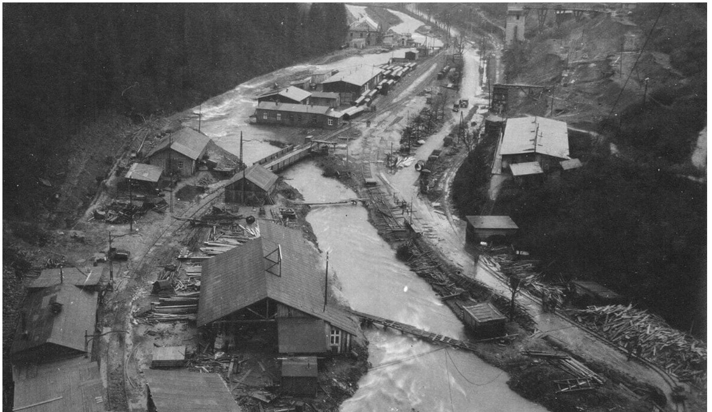
Abb. 1: Historisches Foto der Aggertalsperre im Bau ©Aggerverband
