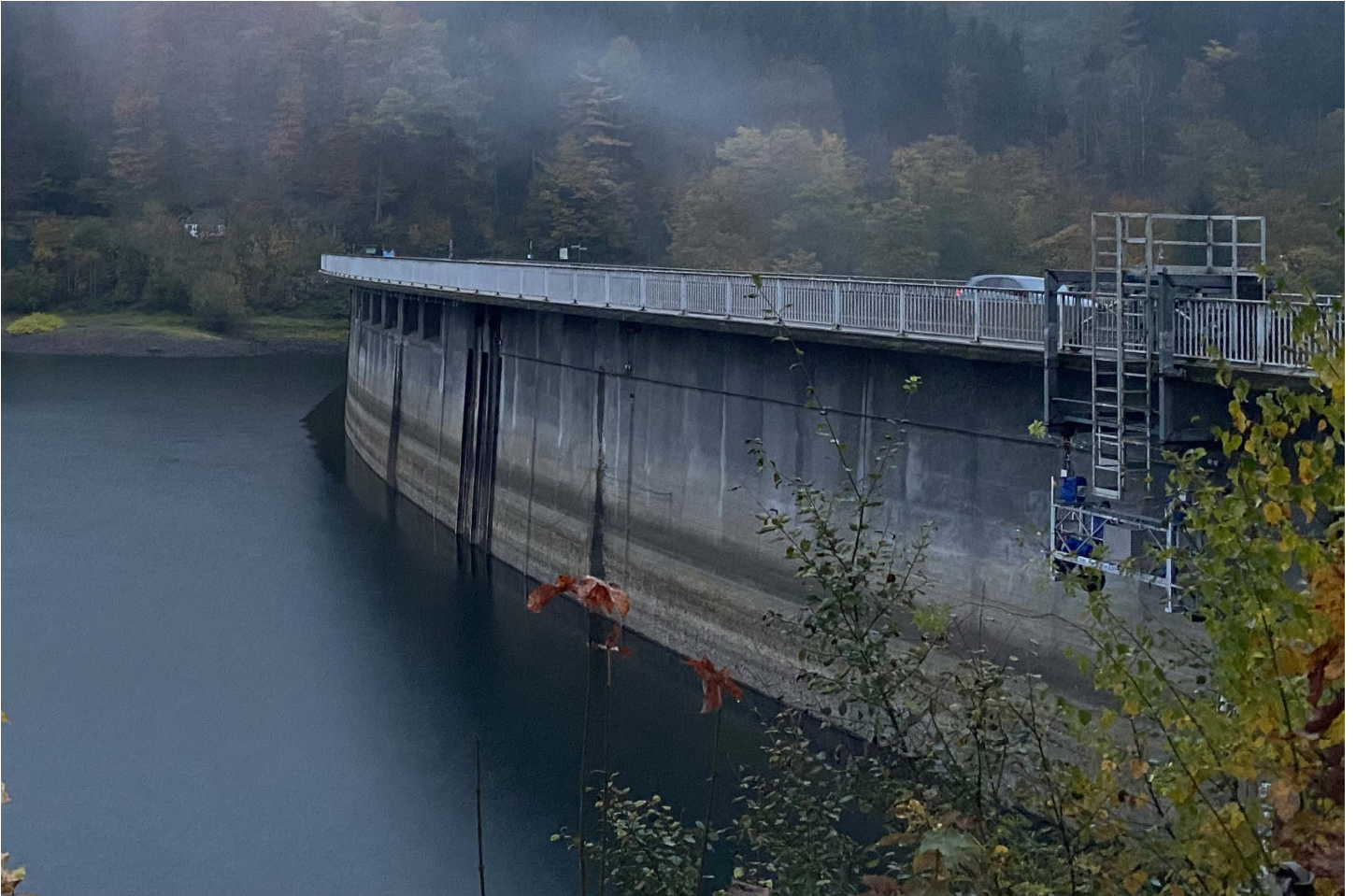
Abb. 26: Staumauer - geringe Sichtbarkeit des Bauwerks
