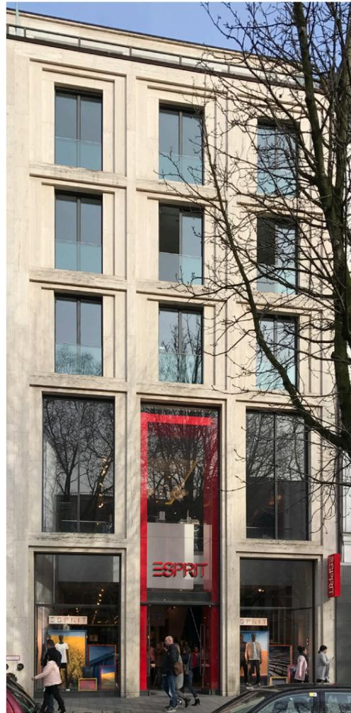
Bei Änderungen, Erneuerungen, Umbaumaßnahmen und Rekonstruktionen soll die Fassade als einheitliches Ganzes betrachtet werden. Eine vertikale Gliederung mit hochrechteckigen Öffnungen ist die Leitlinie (bei den Gebäuden, die vor der Moderne errichtet wurden). Insgesamt sind die Merkmale der Lochfassade zu berücksichtigen. Auf durchgehende Fensterbänder soll bei der Fassadengestaltung verzichtet werden.
