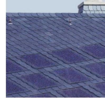
Multikristalline Solarmodule auf einem Schieferdach
