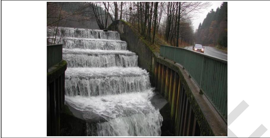
Abbildung 41: Querbauwerk Nr. 970; mehrstufiges Wehr, laut ELWAS 10m Höhendifferenz
