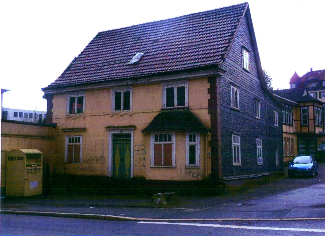
Straßenansicht (Foto: Dolhausen, Stadt Gummersbach)
