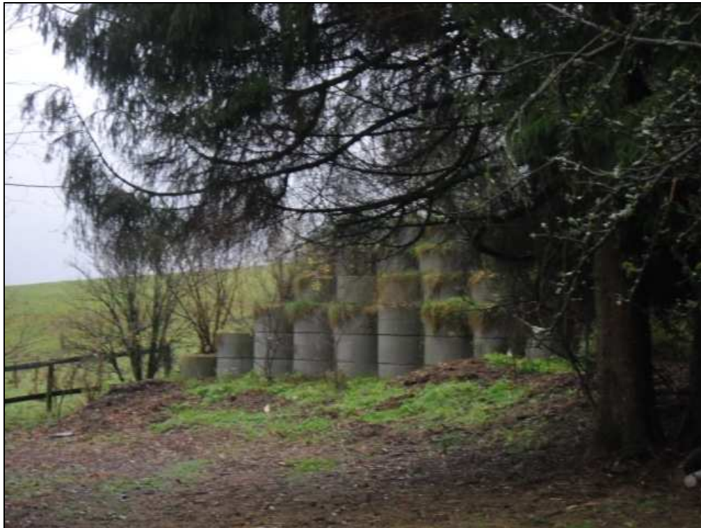
Foto 4: Blick auf die Böschungssicherung des angrenzenden Gewerbegebietes
