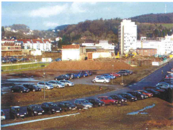
östlicher Planbereich mit ehemaliger Produktionshalle
